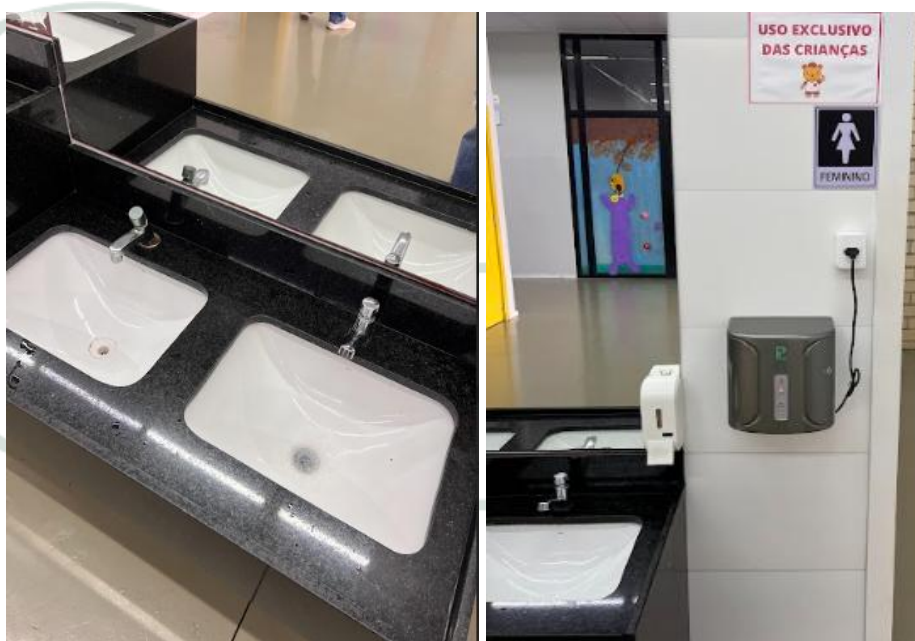
Figura 38. Torneiras com temporizador e secador de mãos automático. Fonte: do autor, 2025.
