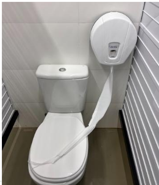
Figura 39. Vaso sanitário com caixa acoplada e sistema Dual Flush. Fonte: do autor, 2025.
